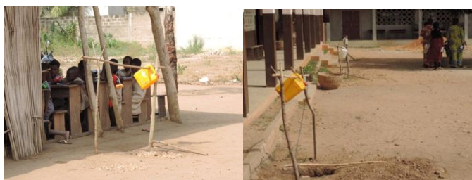
Système dit « TIPPY TAP » de lavage des mains à l'eau et au savon installé devant chaque classe à l'EPP Yénawa (Lokossa)
